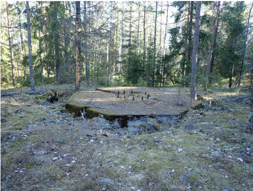
Kuva 2. Ilmatorjuntatykin nro 7 betoninen jalusta. Jalusta on sammaloitunut ja ympärillä kasvaa puustoa.
